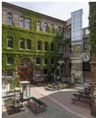
Der Wilde Wein wurde während der Fassadenrestaurierung abgenommen, eingepackt und in Folge wieder angebracht.
