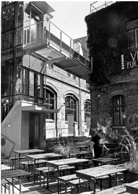
Blick in den fertig sanierten WUK-Hof
